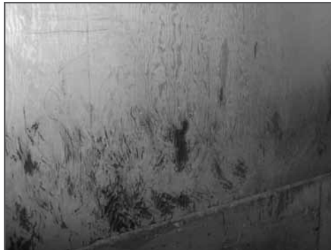
Photo 1. Contre-plaqué peinturé avec usure par les lavages répétitifs.
