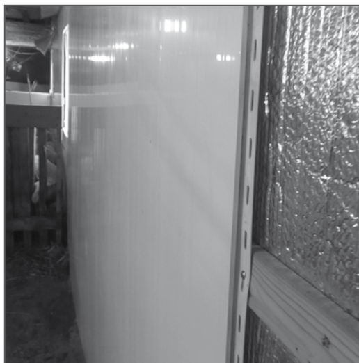
Photo 7. Panneau de PVC avec enclenchement vue de l'installation.
